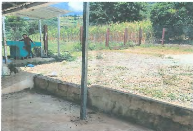
Foto 3: Mejoramiento de piso
